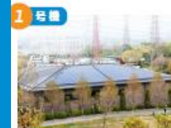
1号機 エコパーク21屋上(北田原町) 2014年3月完成 太陽電池総容量 53.2kW
