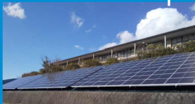
2号機 南こども園屋上(小平尾町) 2016年3月完成 太陽電池総容量 57.9kW
